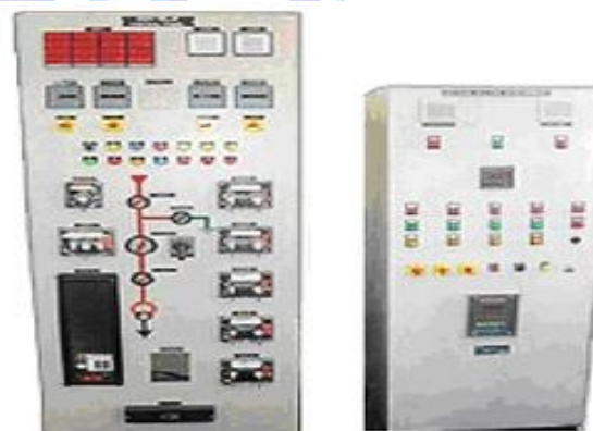
شکل ۱ پانل درون اتاق کنترل
